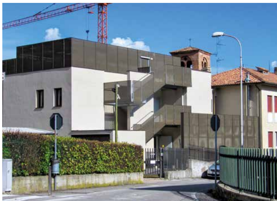
Casa di Riposo di Nembro: particolare della struttura vista da Nord.
