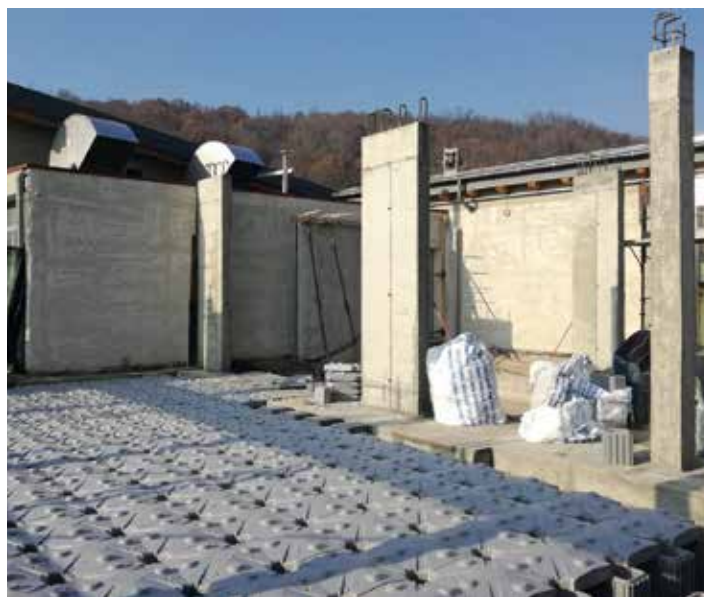
I lavori per la costruzione dei nuovi spogliatoi sono iniziati il 26 novembre; nella foto: il vespaio e i casseri pronti per la gettata di cemento.
